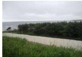
右) 仙台港緩衝緑地は津波被害に耐え健全な形で残っていた。
